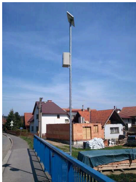
Obr. č. 21 Měřicí stanice se solárním panelem
