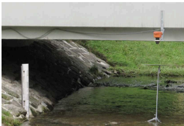
Obr. č. 13 Chybná instalace ultrazvukové sondy.
