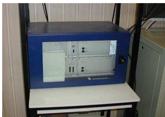
Obr. č.24 Vysílač v objektu u stožáru
