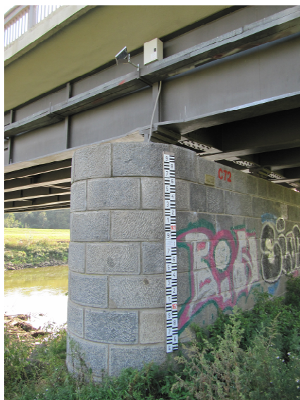
Obr. č. 17 Vodočet pro dílčí část hladiny Obr. č. 18 Vodočet pro celý rozsah hladiny
