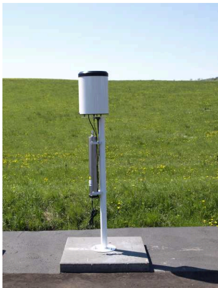
Obr. č. 19 Správně provedená instalace srážkoměru se záchytnou plochou 200 cm 2
