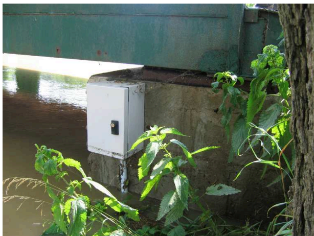
Obr. č. 22 Chybná instalace měřicí stanice (ve spodní části měřicí stanice je vidět pozice maximální dosažené hladiny)
