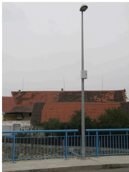
Obr. č. 20 Měřicí stanice dobíjena ze sloupu veřejného osvětlení
