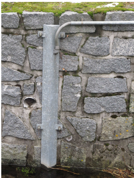
Obr. č. 16 Správně provedena instalace manometrické sondy
